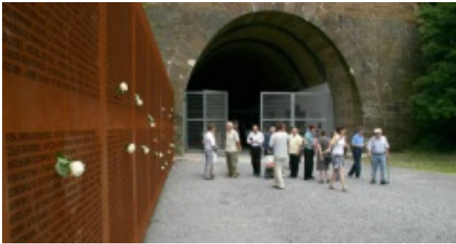
Der Tunneleingang des alten Engelbergtunnels und die Namenswand
